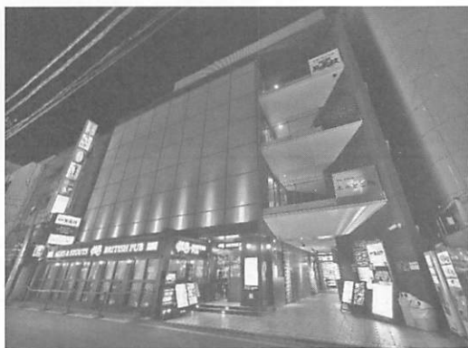
〔エフテム RONビル〕 横浜市神奈川区鶴屋町2-16-10
